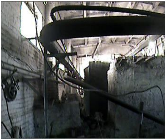
Отсутствует тепловая изоляция
