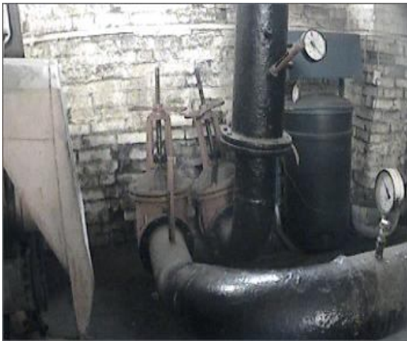
Отсутствует тепловая изоляция
