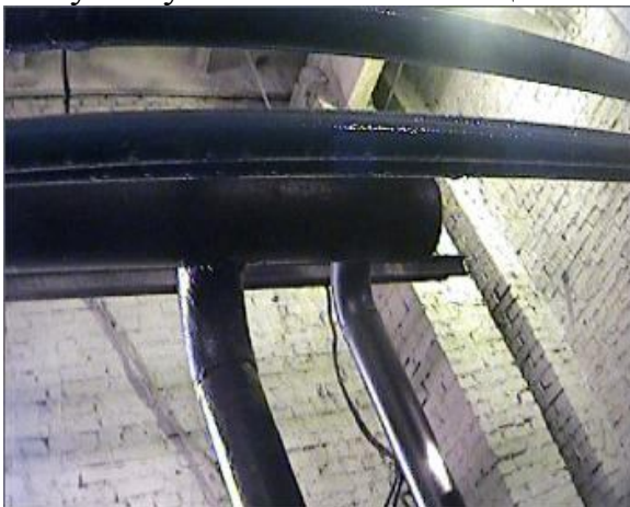
Отсутствует тепловая изоляция
