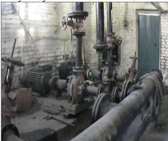
Отсутствует тепловая изоляция
